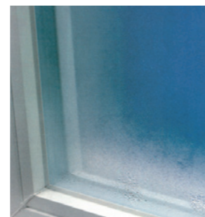
S konvenčními kovovými rámečky je kondenzace běžnou záležitostí.
