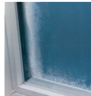
Dokonce i redukované kovové rámečky (nerez) přenášejí teplo, proto stále dochází ke kondenzaci.
